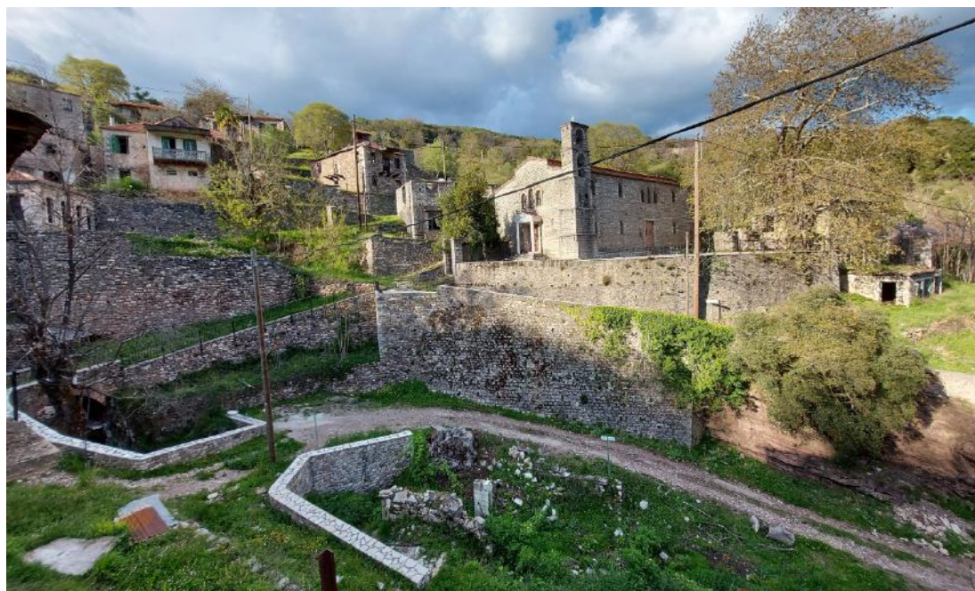
Εικόνα 3-27. Οι διαδοχικοί τοίχοι αντιστήριξης στο κεντρικό πλάτωμα με ιδιαίτερα μεγάλο ύψος, συγκροτούν και συγκρατούν τον πυρήνα του οικισμού. Πηγή: Ερευνητική ομάδα ΕΜΠ, 2023.
