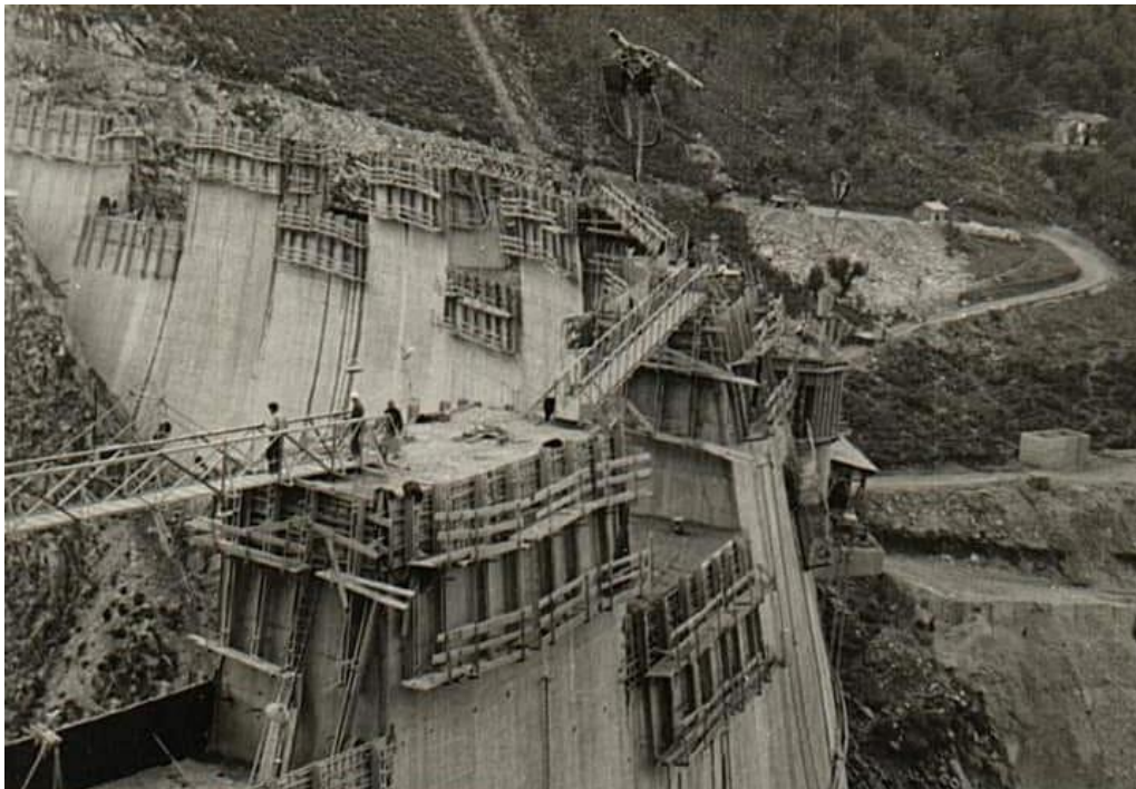
Εικόνα 1-31. Κατασκευή φράγματος Πλαστήρα 1959. Πηγή: Φωτογραφικό Αρχείο ΔΕΗ.
