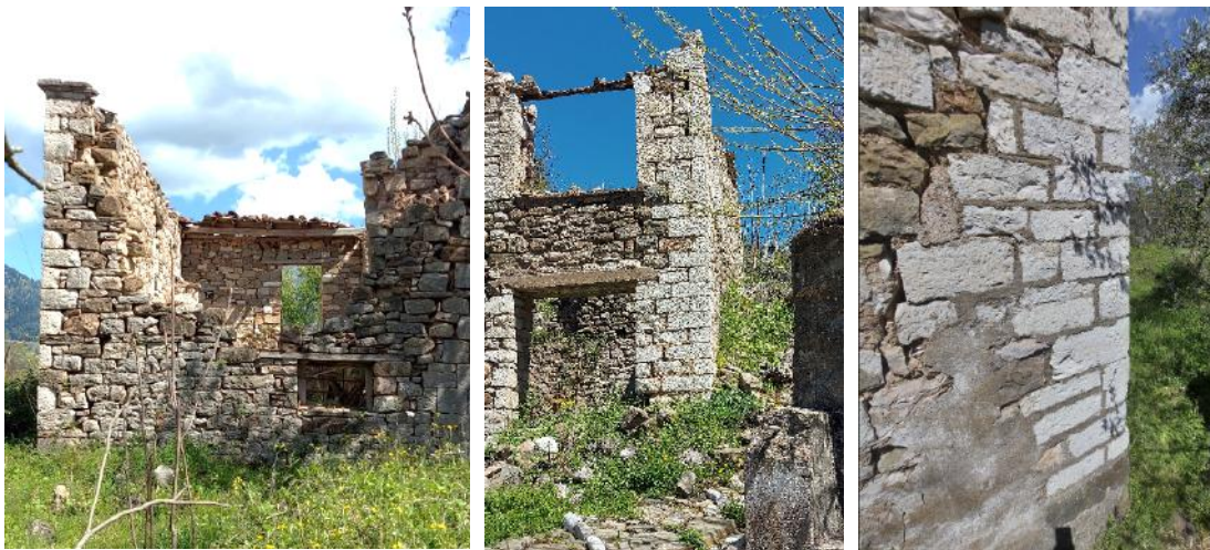
Εικόνα 3-32. Γωνίες κτιρίων ενισχυμένες με μεγαλύτερη επιφάνεια λίθων με λαξευτά πρόσωπα. Πηγή: Ερευνητική ομάδα ΕΜΠ, 2023.
