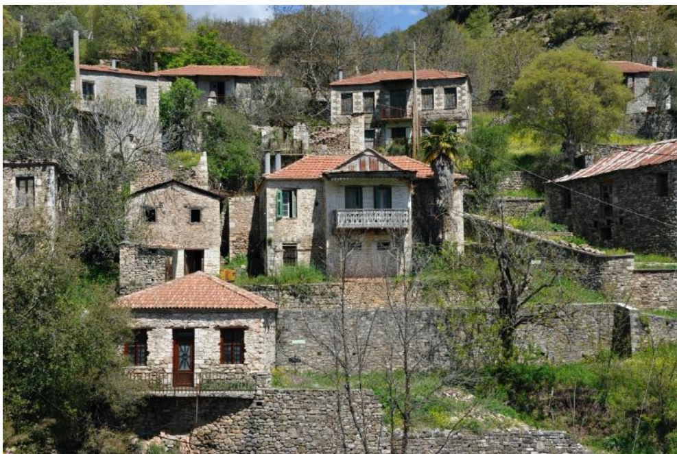
Εικόνα 3-24. Το ισόγειο κοινοτικό κατάστημα και η Οικία «του Σβώλου» στην κεντρική γειτονιά της Βίνιανης. Πηγή: Ερευνητική ομάδα ΕΜΠ, 2023.
