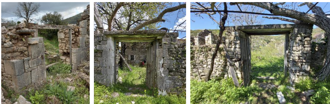
Εικόνα 3-38. Αυλόπορτες κατασκευασμένες με παραστάδες από λίθους με λαξευτά πρόσωπα. Το ανώτερο τμήμα τους στην περιοχή του ανωφλίου έχει αντικατασταθεί με πλάκα οπλισμένου σκυροδέματος. Πηγή: Ερευνητική ομάδα ΕΜΠ, 2023.
