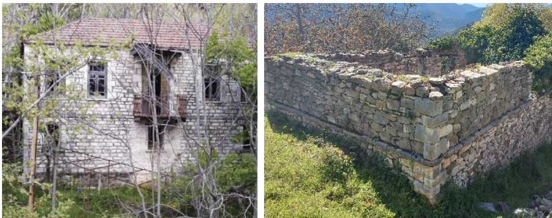
Εικόνα 3-33. Ημιλαξευτές προεξέχουσες ζώνες στο επίπεδο των πατωμάτων σε δύο κτίρια του οικισμού. Αριστερά η Οικία Καραγεώργου. Πηγή: Ερευνητική ομάδα ΕΜΠ, 2023.
