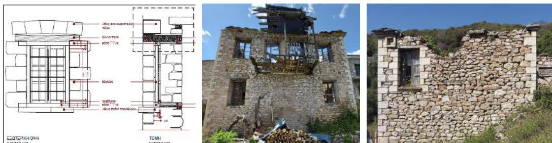
Εικόνα 3-36. Διαμόρφωση ανωφλίων και παραστάδων παραθύρων με χθαμαλό τόξο πάνω από το ξύλινο πρέκι αριστερά και μόνο με ξύλινο πρέκι κέντρο και δεξιά. Πηγή: Ερευνητική ομάδα ΕΜΠ, 2023. Σχέδια: Α. Βιέννα, Α. Ζαχαράκη, Ζ. Κονδύλη, Ν. Σάκκα, Β. Λασπιά, Ο. Σπυριδάκη, Α. Στεφανή, Δ. Χρήστου, μεταπτυχιακές φοιτήτριες ΔΠΜΣ «Προστασία Μνημείων» ΕΜΠ.
