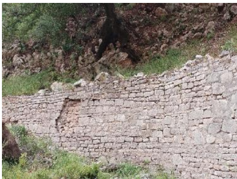
Εικόνα 3-59. Καταστροφές στο λιθόκτιστο τοίχείο αντιστήριξης του μονοπατιού ανόδου στη γέφυρα από τα ανατολικά. Πηγή: Ερευνητική ομάδα ΕΜΠ, 2023.
