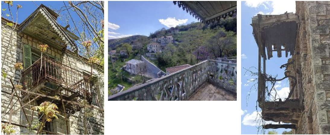
Εικόνα 3-43. Ξύλινοι εξώστες με ξύλινα και μεταλλικά κάγκελα. Πηγή: Ερευνητική ομάδα ΕΜΠ, 2023.
