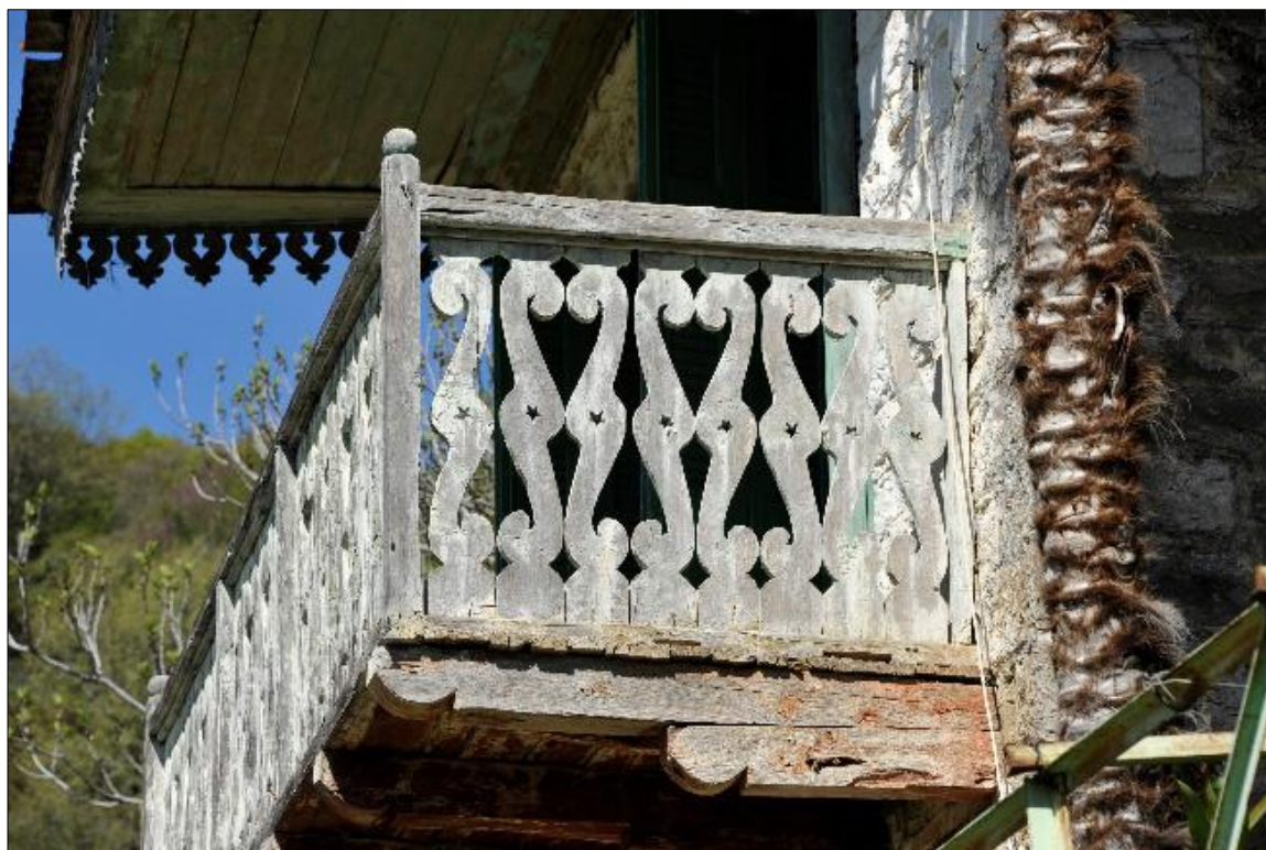
Εικόνα 3-12. Ξύλινα κιγκλιδώματα και κρεμαστοί νεροσταλάκτες με μορφή σταγόνας σε στεγασμένο εξώστη. Πηγή: Ερευνητική ομάδα ΕΜΠ, 2023.
