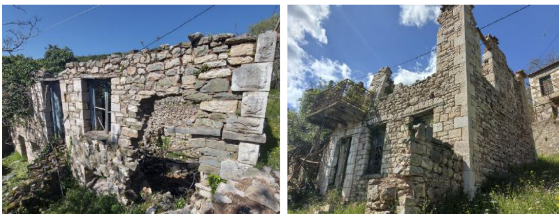
Εικόνα 3-30. Γωνιόλιθοι με αδρά λαξευμένα πρόσωπα με λαξευτή διακοσμητική ταινία στην περίμετρό τους (αριστερά), γωνιόλιθοι με επιμελημένη λάξευση σε όλη την επιφάνεια των προσώπων τους (δεξιά). Στο ανώτερο τμήμα της γωνίας υπάρχει διακοσμητικό μοτίβο σε γωνιόλιθο καθώς και η ημερομηνία κατασκευής του κτιρίου. Πηγή: Ερευνητική ομάδα ΕΜΠ, 2023.
