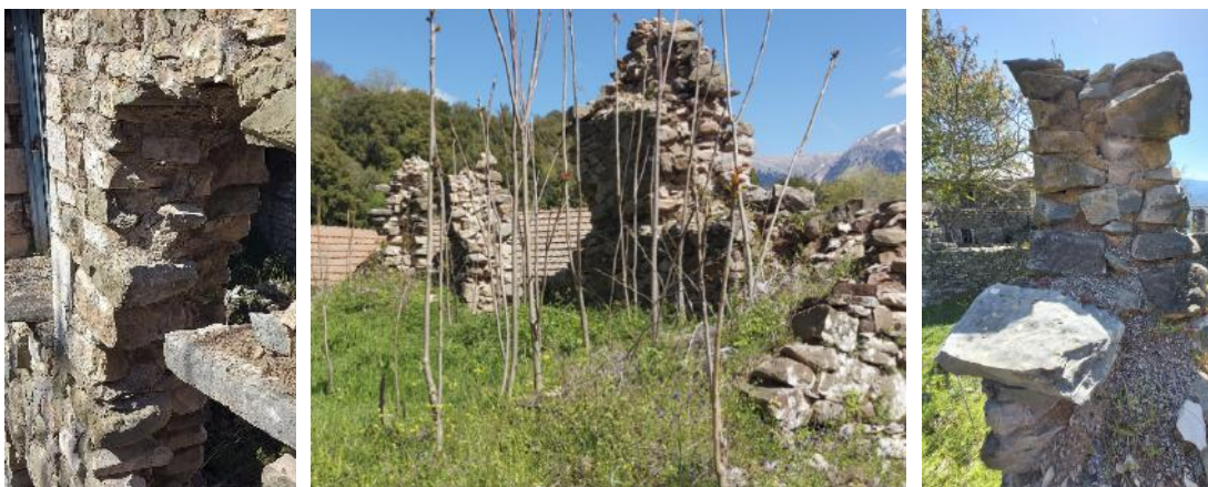
Εικόνα 3-29. Τρίστρωτες τοιχοποιίες. Πηγή: Ερευνητική ομάδα ΕΜΠ, 2023.
