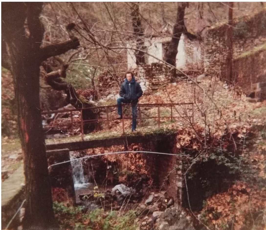
Εικόνα 3-46. Χαρακτηριστική εικόνα του ρέματος της δεκαετίας 1980. Διακρίνεται η μικρή γέφυρα, το μονοπάτι και το ισόγειο κτίσμα ταβέρνας-ψησταριάς στα ανάντη της κρήνης της Βίνιανης. Αυτή η διαμόρφωση και το κτίριο καταστράφηκαν ολοσχερώς τα επόμενα χρόνια, μετά από μία πλημμύρα που προκάλεσε αστοχία επιχωματώσεων σε ψηλότερο σημείο. Φωτό: Κώστας Μονιάς.
