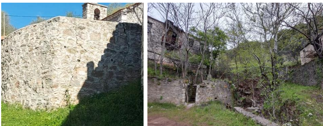
Εικόνα 3-47. Τοίχοι αντιστήριξης με σημαντικές βλάβες. Πηγή: Ερευνητική ομάδα ΕΜΠ, 2023.
