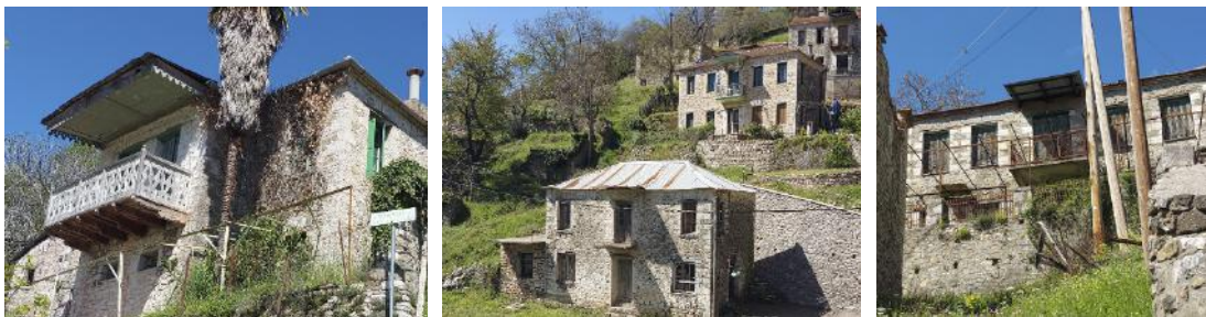
Εικόνα 3-44. Ο καλύτερα διατηρημένος ξύλινος εξώστης της Οικίας «του Σβώλου» (αριστερά). Εξώστες από οπλισμένο σκυρόδεμα που αντικατέστησαν ξύλινους. Πηγή: Ερευνητική ομάδα ΕΜΠ, 2023.
