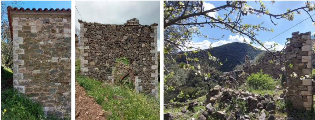
Εικόνα 3-31. Αργολιθοδομές με γκρι λίθους και λευκούς γωνιόλιθους. (περιοχή Οικίας «του Δασκάλου»). Πηγή: Ερευνητική ομάδα ΕΜΠ, 2023.
