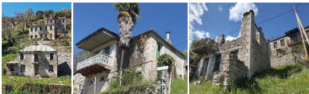
Εικόνα 3-9. Διώροφα και ημιδιώροφα κτίρια στη Βίνιανη. Πηγή: Ερευνητική ομάδα ΕΜΠ, 2023.
