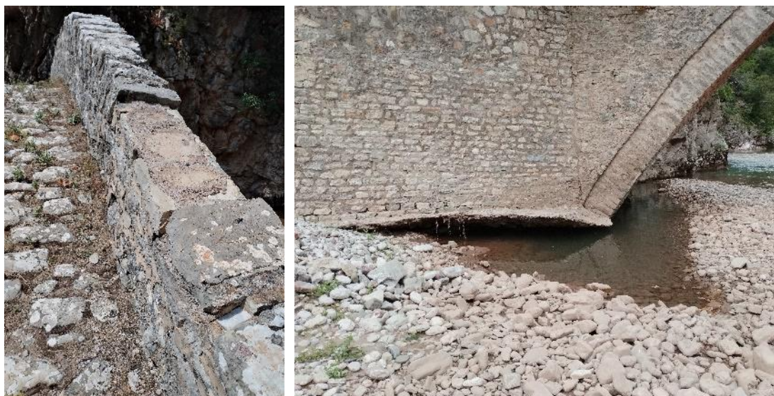
Εικόνα 3-57. Απώλεια λίθων στο στηθαίο της γέφυρας. Πηγή: Ερευνητική ομάδα ΕΜΠ, 2023.
