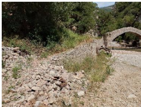
Εικόνα 3-59. Καταστροφές στο λιθόκτιστο τοίχείο αντιστήριξης του μονοπατιού ανόδου στη γέφυρα από τα ανατολικά. Πηγή: Ερευνητική ομάδα ΕΜΠ, 2023.
