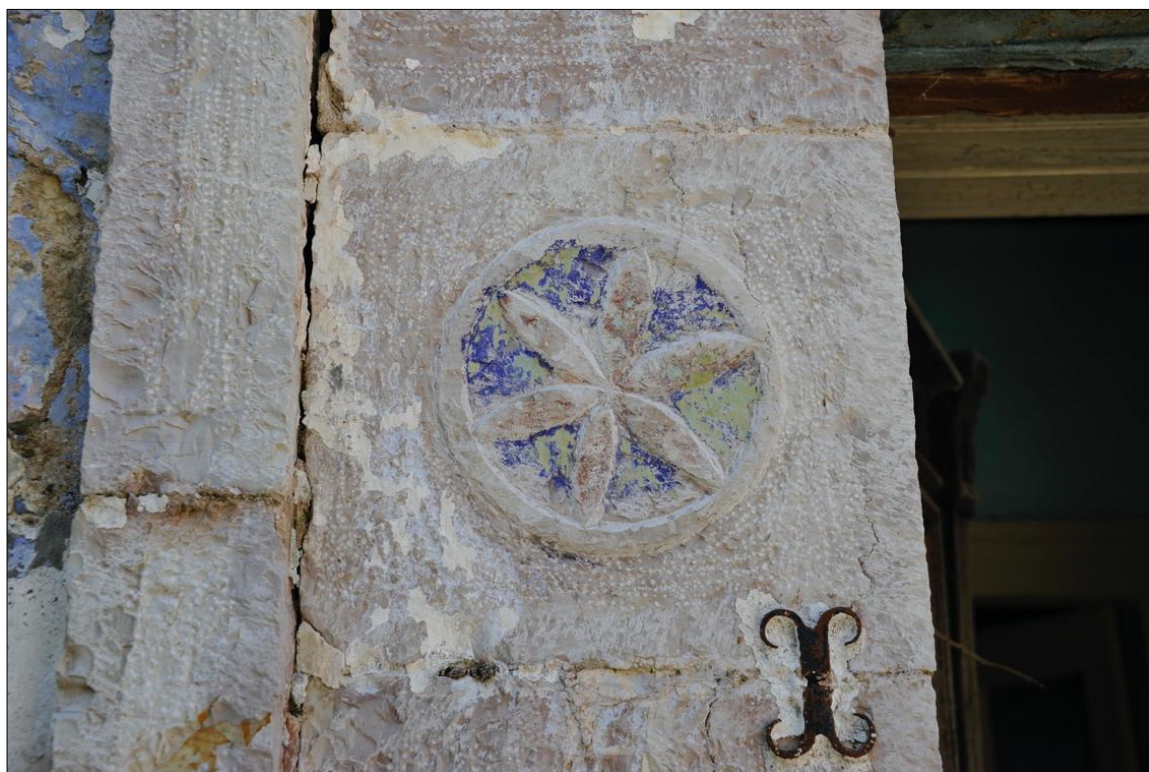
Εικόνα 3-11. Διακοσμητικό ανάγλυφο; ρόδακας σε δόμο παραστάδας εξώθυρας και σφυρήλατος μεταλλικός σύνδεσμος «φουρκέτα», αγκύρωσης της ξύλινης κάσας. Πηγή: Ερευνητική ομάδα ΕΜΠ, 2023.
