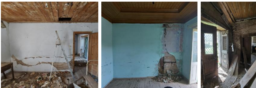
Εικόνα 3-34. Ξύλινοι διαχωριστικοί τοίχοι από μπαγδατί στο όροφο (αριστερά-Οικία «του Δασκάλου» και κέντρο-Οικία «του Σβώλου») και στο ισόγειο (δεξιά-Οικία Νικόπουλου). Πηγή: Ερευνητική ομάδα ΕΜΠ, 2023.
