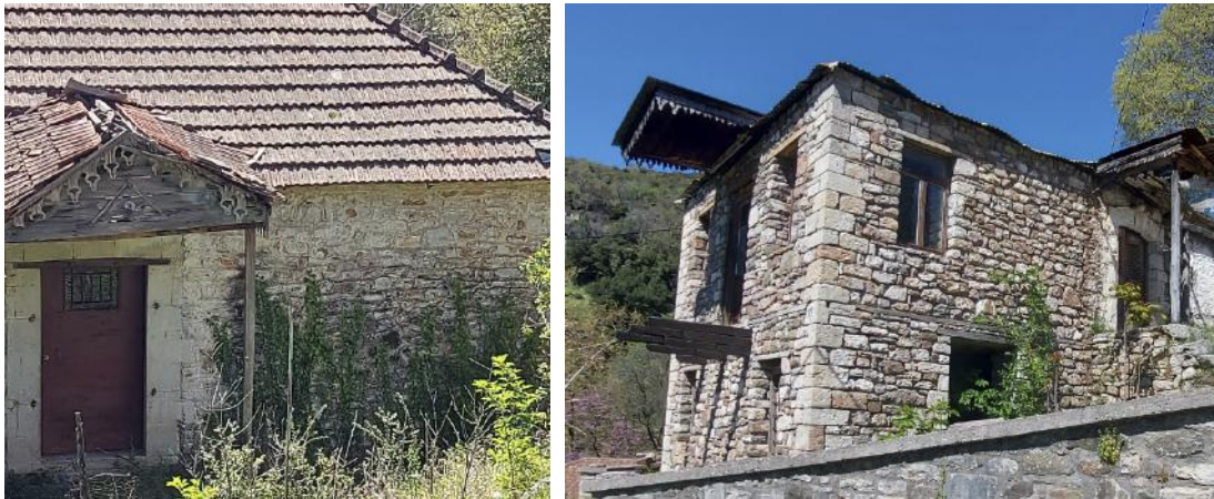
Εικόνα 3-45. Ξύλινα στέγαστρα με ξυλόγλυπτες διακοσμητικές «σταγόνες» οι οποίες είχαν και χρήση νεροσταλάκτη, επάνω από κύριες εισόδους. Πηγή: Ερευνητική ομάδα ΕΜΠ, 2023.
