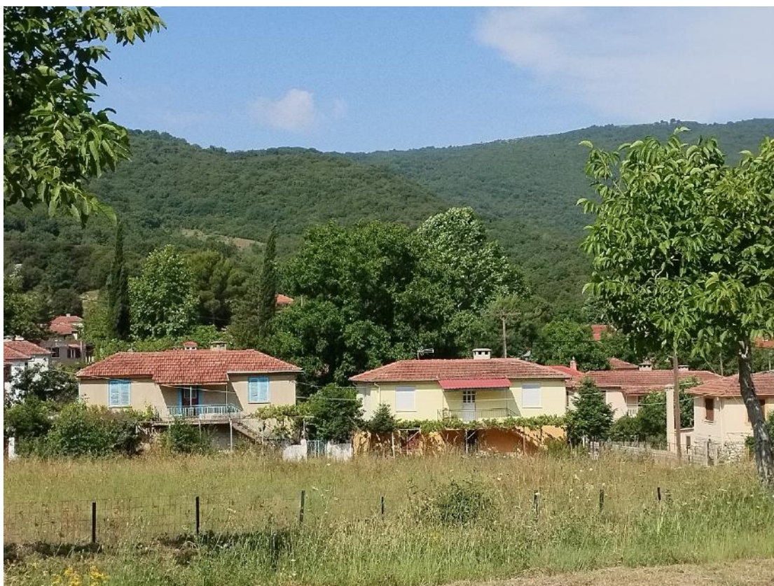
Εικόνα 5-9. Τυπικά διώροφα οικήματα οργανωμένης δόμησης της Νέας Βίνιανης, με κατοικία στον όροφο, στεγασμένο εξώστη εισόδου, εξωτερική κλίμακα ανόδου και κατώι ή εργαστήριο στο ισόγειο. Πηγή: Ερευνητική ομάδα ΕΜΠ, 2023.
