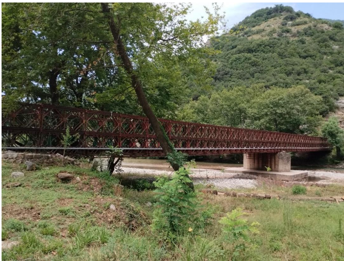
Εικόνα 2-23. Η νέα μεταλλική γέφυρα τύπου Μπέιλι στον Μέγδοβα. Κατασκευάστηκε από τον στρατό το 1947. Σε απόσταση 50 περίπου μέτρων στα κατάντη, το «καρέλι» -ο ενάერიος κλωβός μεταφοράς- διέσχιζε το ποτάμι. Πηγή: Ερευνητική ομάδα ΕΜΠ, 2023.
