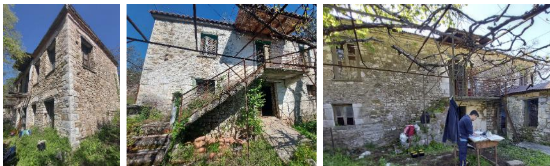
Εικόνα 3-26. Διώροφο κτίριο -Οικία Καραγεώργου- (αριστερά), ημιδιώροφο κτίριο με εξωτερικό κλιμακοστάσιο (κέντρο), διώροφο κτίριο με εξωτερικό κλιμακοστάσιο (δεξιά-Οικία «του Δασκάλου»). Πηγή: Ερευνητική ομάδα ΕΜΠ, 2023.
